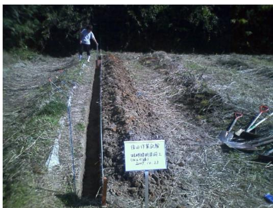
図1 畦畔側近への明渠施工
