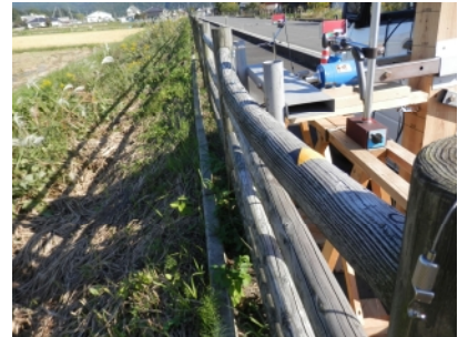
図-1 強度試験の状況
