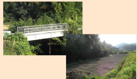
架け替えた農道橋及び再生利用された農地
