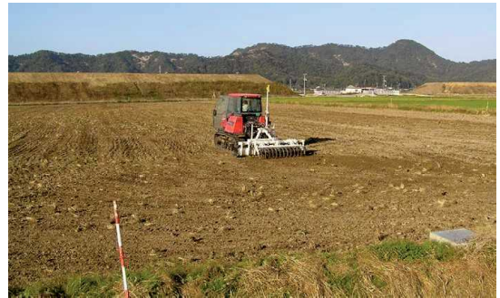
レーザーレベラーによる均平作業
