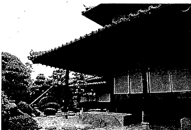
5. 主屋一階座敷 縁部分
