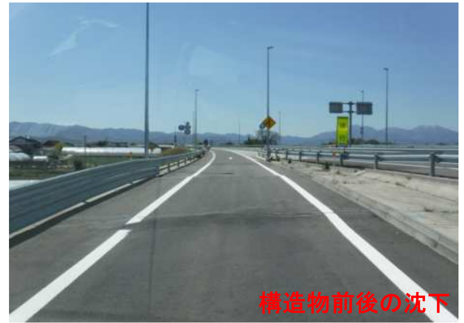
路面沈下によるうねり
