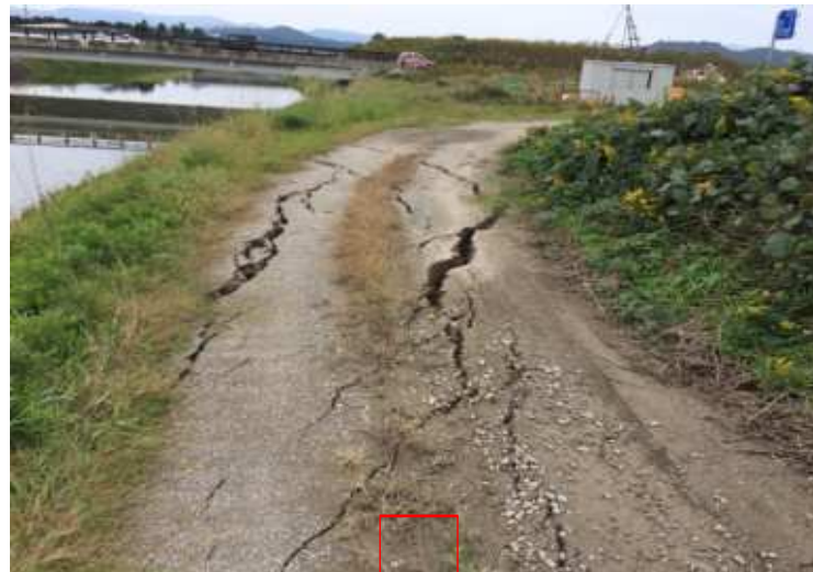
北条川放水路（北栄町弓原）
