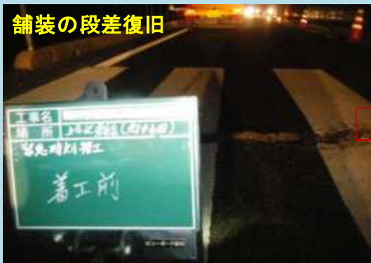
橋梁継手の段差復旧
