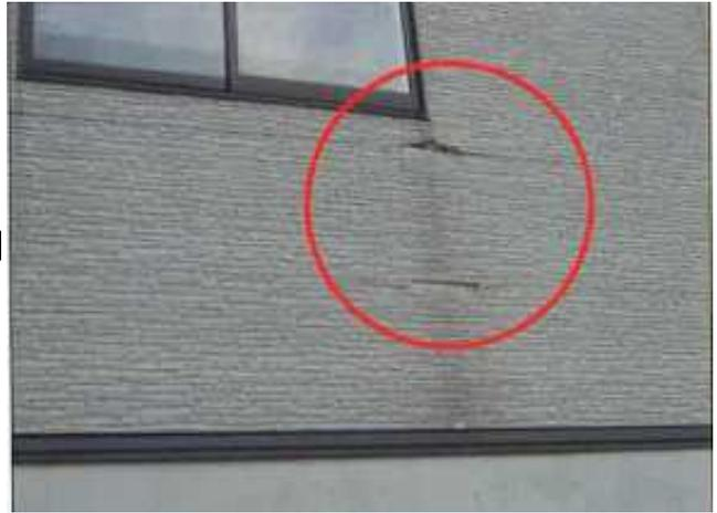
3 屋根瓦小規模被災+外壁中規模被災
