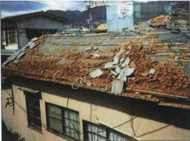
2 屋根瓦中規模被災+外壁小規模被災
