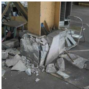
倉吉梨選果場(支柱破損)
