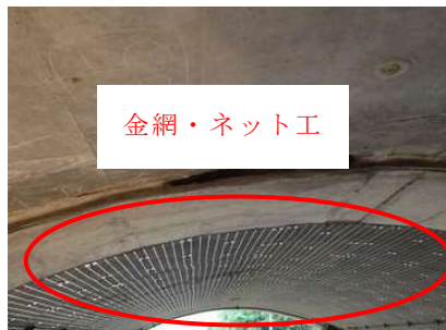
写真2.3 金網・ネット工の事例
