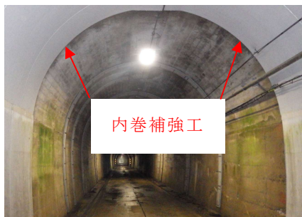
写真2.2 内巻補強工の事例
