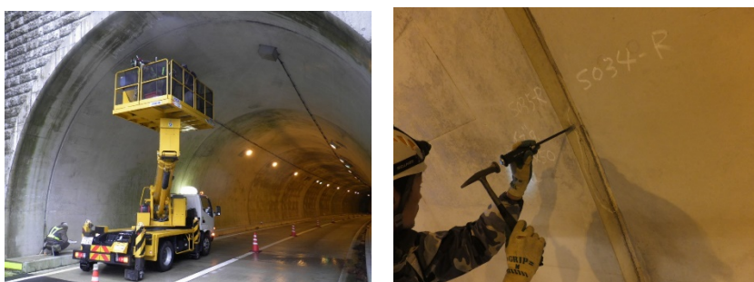
写真4.1 定期点検状況
