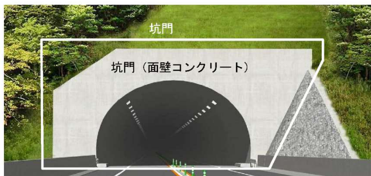
図4.1 トンネル本体工点検箇所
