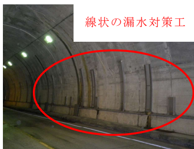
写真2.4 線状の漏水対策工の事例
