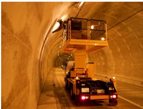
写真2.1 点検状況写真(左:トンネル定期点検、右:定期パトロール(非常用施設点検))
