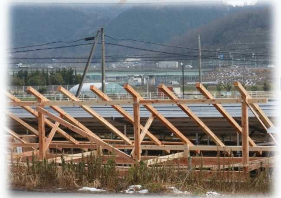
県産材を利用した太陽光パネルの架台
