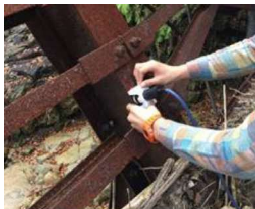
鋼板腐食検査器を使用した調査
