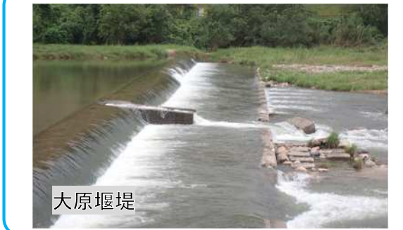
現在小わざ魚道を整備中の堰堤
