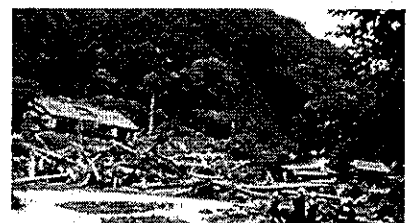
【砂防】福岡県奈良ヶ谷川（家屋被害）
