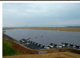
鳥取空港発電所
