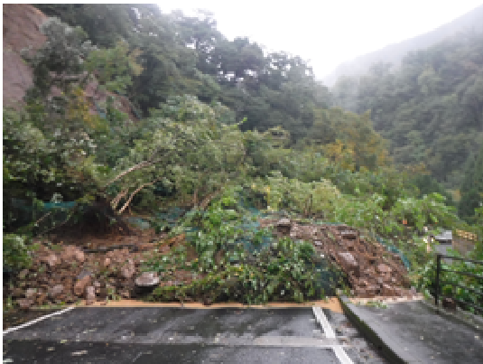
県道鳥取鹿野倉吉線 (三朝町三徳) 法面崩落
