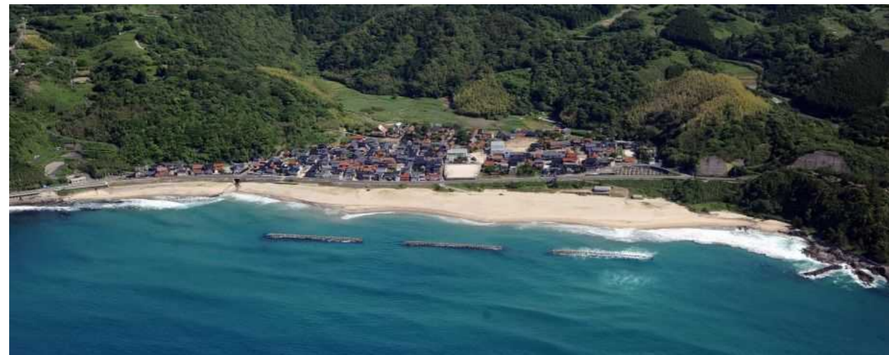
図 3.2.24 宇野海水浴場の状況（H28.6 撮影）
