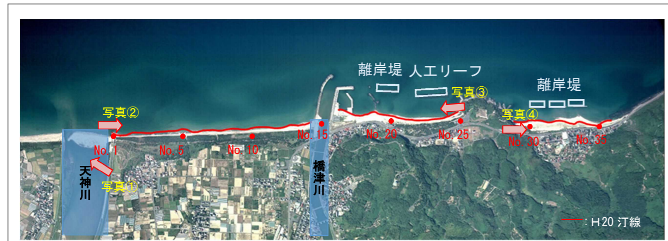
図 3.2.20 天神川右岸地区の長期的な汀線変化状況図(2/2)
