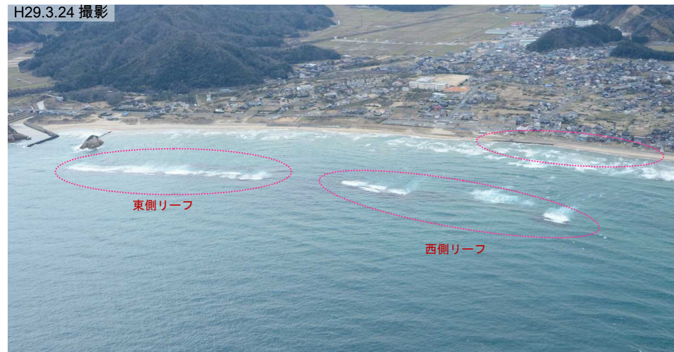
図 3.1.1 H28 年度 浦富地区侵食状況
