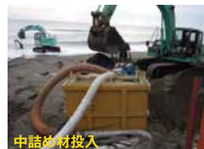
中詰め材投入
