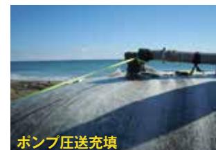
ポンプ圧送充填
