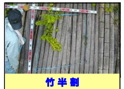
竹半割と竹樺は、日光による変色や微細な割れがみられる程度
