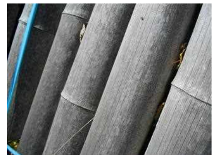
竹半割と竹樺は、日光による変色や微細な割れがみられる程度
