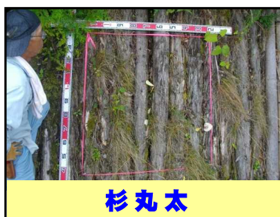
杉丸太は腐朽が進み、繊維状に崩れ始めていた
