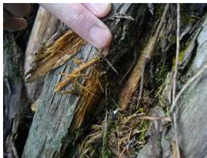
杉丸太は腐朽が進み、繊維状に崩れ始めていた
