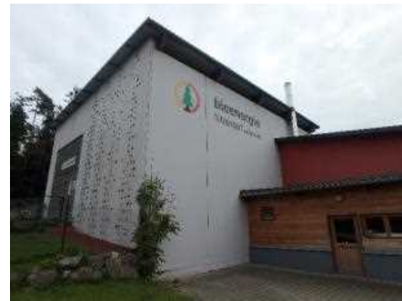
木質バイオマスボイラー
