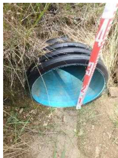
50m毎に暗渠排水
