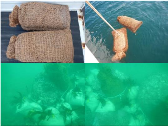
図4 鉄キレート材ビバリーユニットの沈める際（上）と海底に設置後（下）の様子
