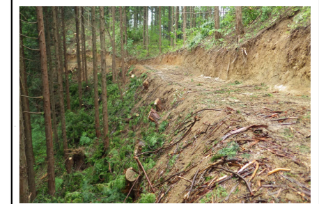
【鳥取式作業道の推進】 災害に強く、長期間の使用に耐えるように、転圧等丁寧な施工と、早期緑化を行うための表土ブロックを施工する作業道の作設を推進している。
