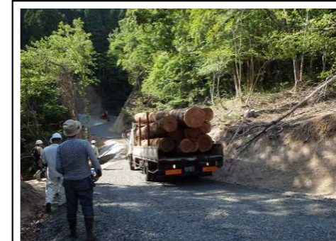
【林業専用道の整備】 林道までの木材運搬は林内作業車や2トン程度のトラックで行われていましたが、大型トラックが通行できる林業専用道を整備することで大幅な時間短縮とコストの削減に繋がっています。(日南町上萩山)
