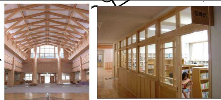
【日南町庁舎・日南小学校】 地域で生産・加工された木材を使用した木造公共施設。地域材利用のシンボル。 日南小学校には(株)オロチのLVL使用。 (日南町霞)
