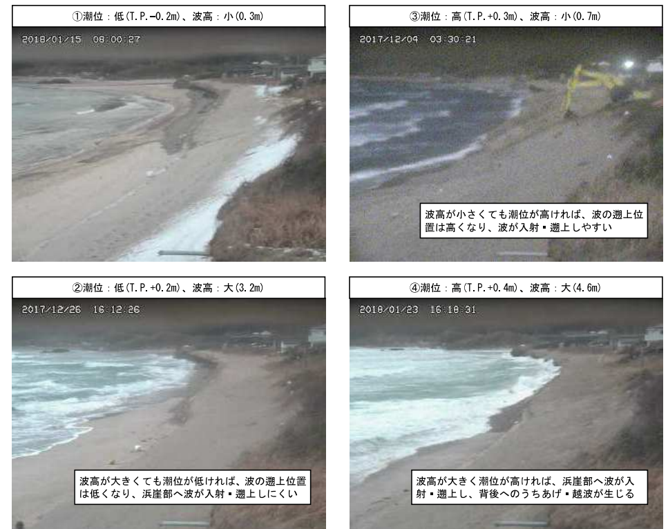
図 3-5 CCTV 画像に基づく潮位・波高による波の遡上状況の違い
