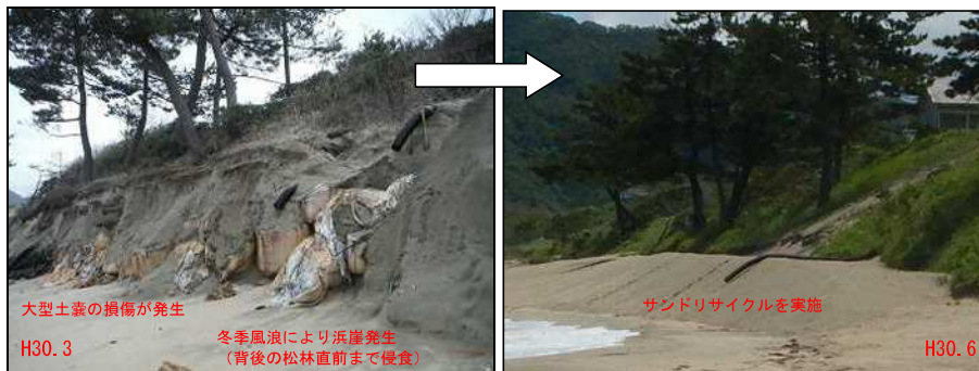
図 5-3 当該箇所の状況（左：H30.3 浜崖状況、右：H30.6 サンドリサイクル実施状況）
