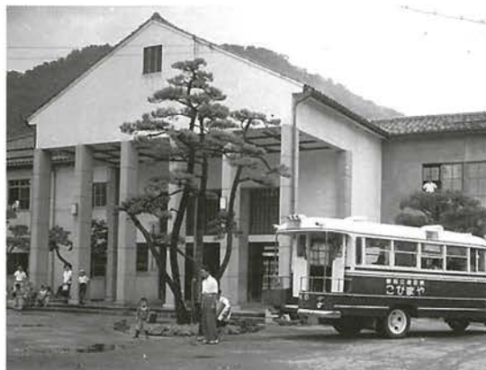
昭和19年建築の庁舎（3代目）
