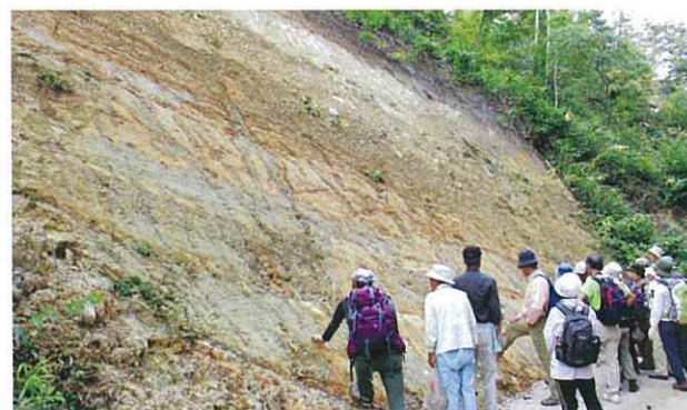
▲林道工事のため地層が露わになっています
