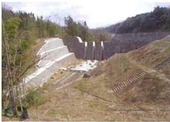
真野 2 号砂防堰堤 (H23 年完成)
