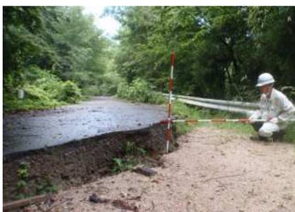
被災状況(県道の亀裂)
