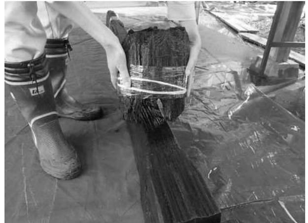
「地中梁」への「柱」の落とし込み（固定）方法
