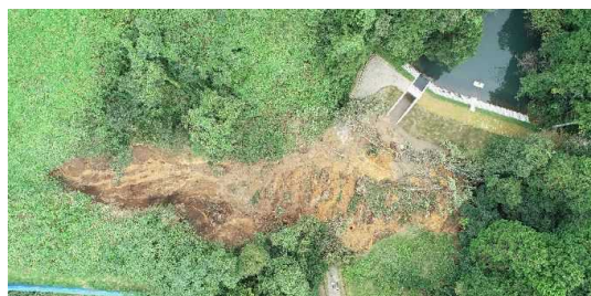
〈ため池管理道と水路への土砂流入(倉吉市尾田)〉
