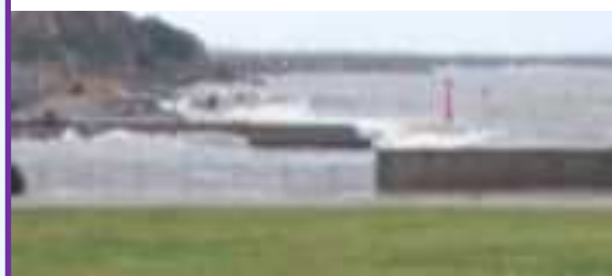
【第8防波堤(西浜地区入口)の越波状況】
