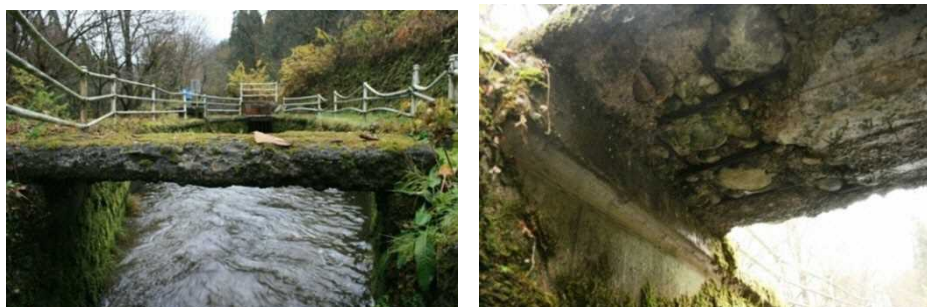
写真-2 竹田谷川支線導水路 沈砂池管理用橋梁劣化状況
