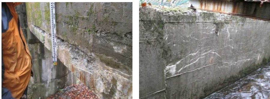
写真-5 管ヶ谷川支線導水路 導水路立坑直上流水路橋劣化状況
