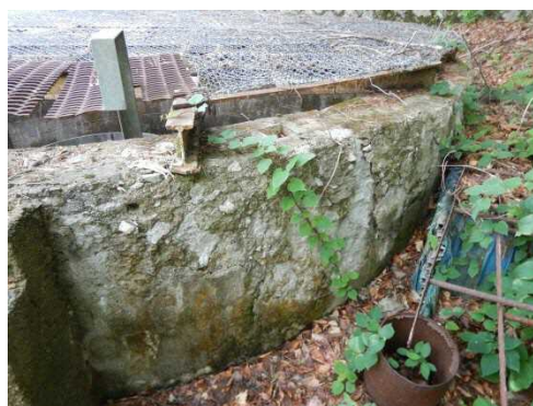
写真-6 調圧水槽 劣化状況
