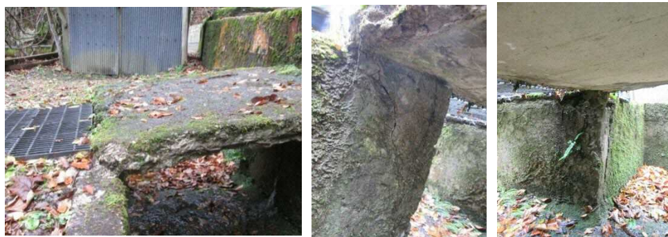
写真-3 菅ヶ谷川支線導水路 沈砂池ゲート操作用スラブ劣化状況
