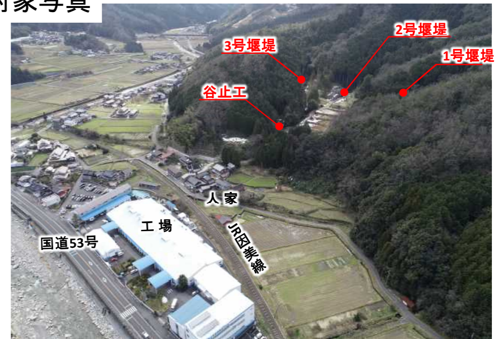
砂防堰堤写真
