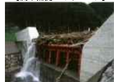
【流木捕捉状況】
