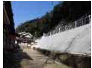
擁壁工の整備
