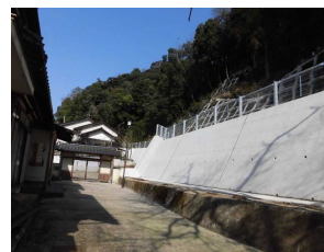
擁壁工の整備
