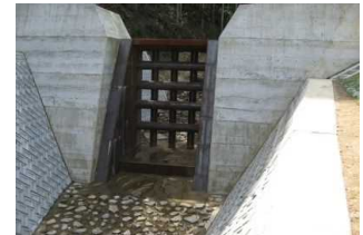
透過型砂防堰堤の新設
