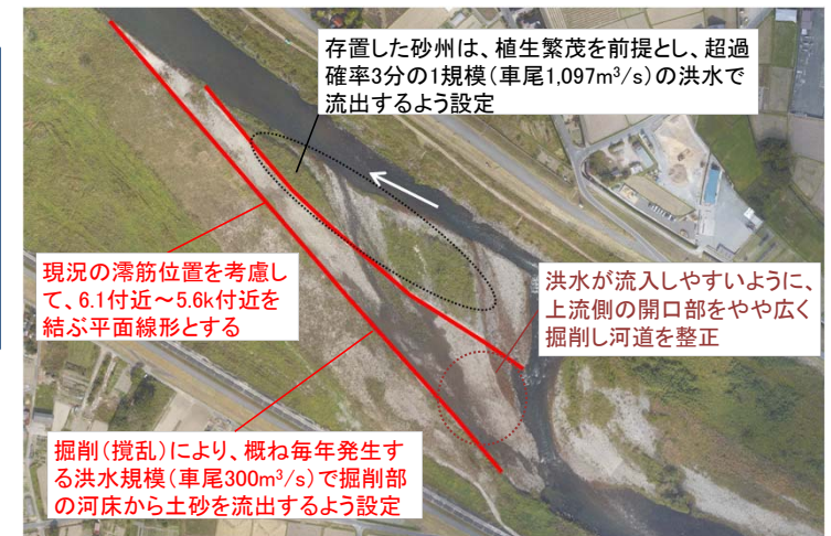
5.8k付近における河道掘削
