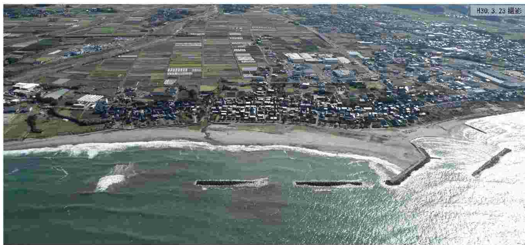
図 14.2.15 由良川左岸地区（逢東船揚場）の上空からの斜め写真
