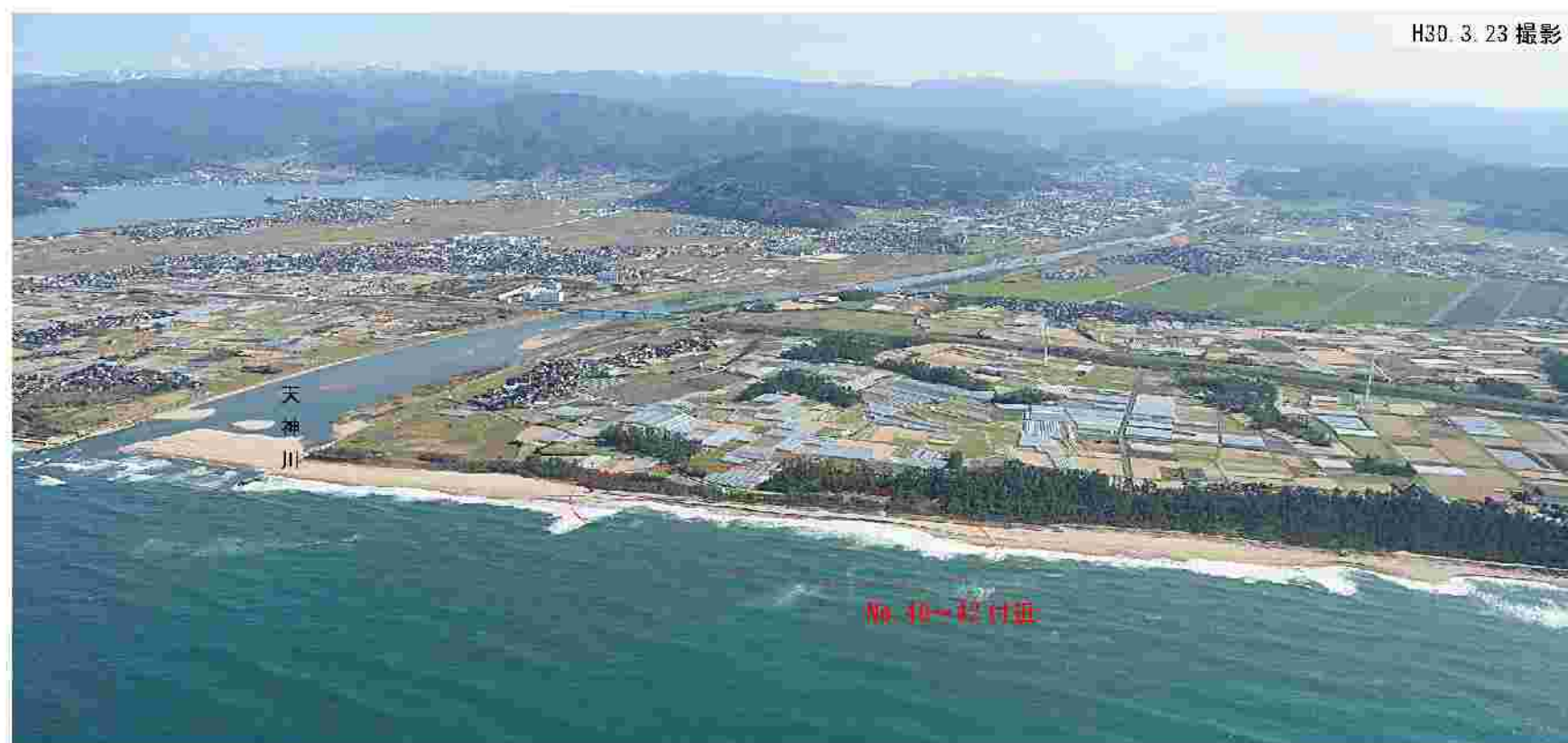
図 14.2.4 天神川左岸地区（東新田場）の上空からの斜め写真
