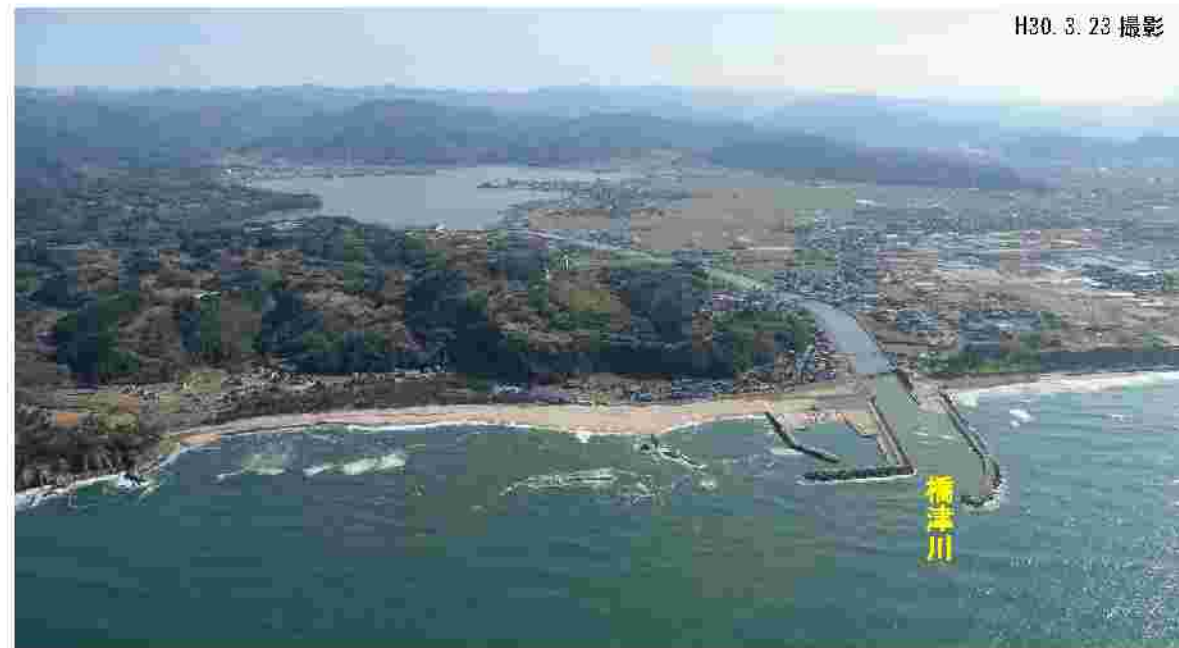
図 14.2.27 天神川右岸地区 (はわい海水浴場) の上空からの斜め写真
