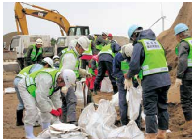
土のう製作作業
