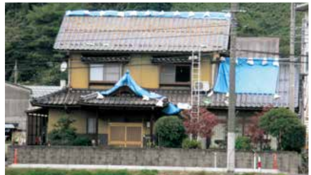
地区内の被災状況
