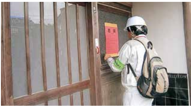
判定ステッカーの貼り付け
