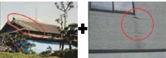
3 屋根瓦小規模被災+外壁中規模被災
