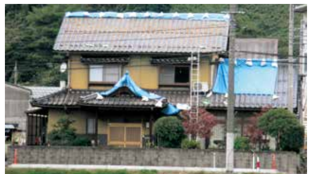
地区内の被災状況
