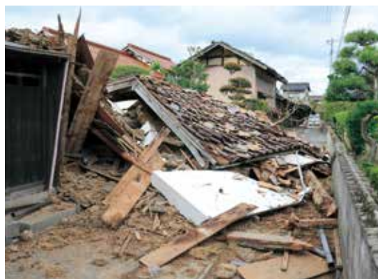
地震によって崩壊した住家
