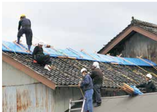
屋根の修繕活動を行うボランティア
