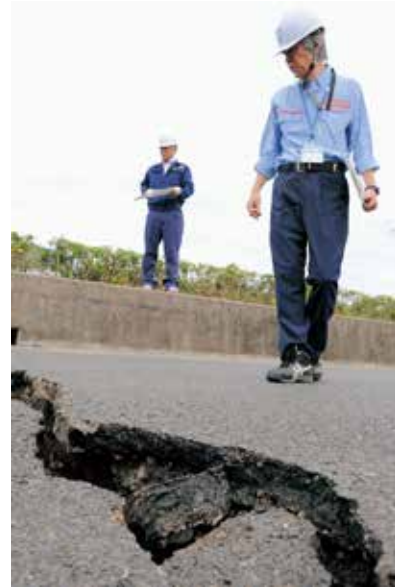
道路の亀裂も多数発生した
