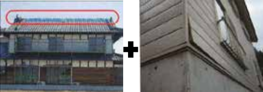
3 屋根瓦小規模被災+外壁中規模被災
