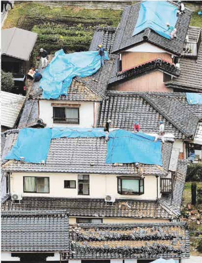
前に壊入、地震で壊れた屋根にブルーシートを張る人たち。22日午前、鳥取県倉吉市共同通信社へりから
