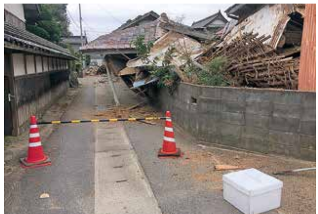
被災家屋周辺の地盤震動調査 （北栄町西園地区、白い箱の中に地震計）
