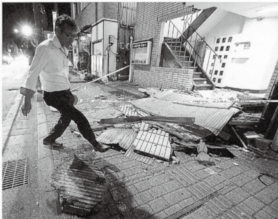
雑居ビルの壁面が崩れ、歩道に散乱した外装のタイル —21日午後6時4分、鳥取県倉吉市、橋本敦撮影
