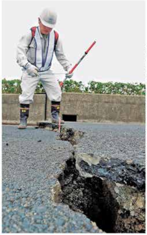
道路の陥没を調べる国土交通省鳥取県川部事務所の職員＝22日午前7時4分、鳥取県北栄町千手
