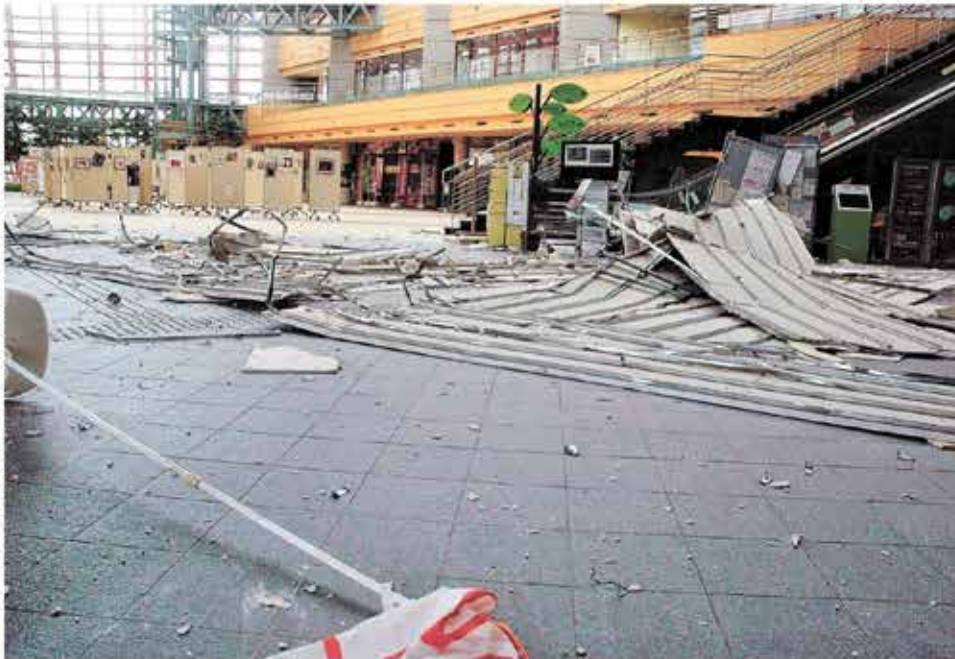
震度6弱の地震が襲い、エントランス付近の天井が落ちた鳥取県立未来中心1。21日午後2時40分、鳥取県鳥取市駐輪場町
