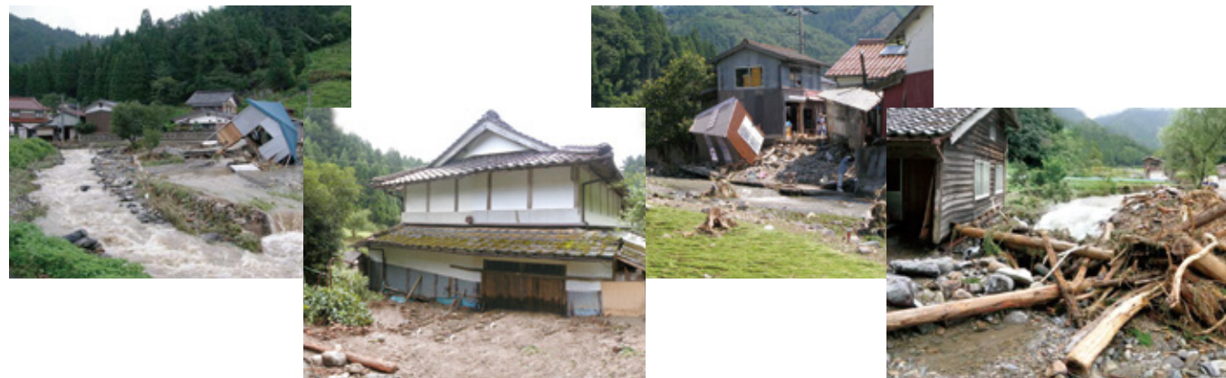
1時間に86mmの大雨が降り、土砂災害が発生。(人家半壊1戸、倉庫全壊3棟)
