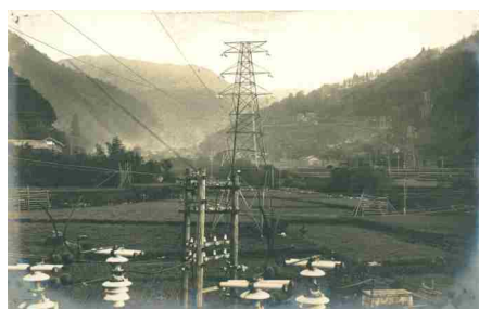
35 山陽水力河合発電所
