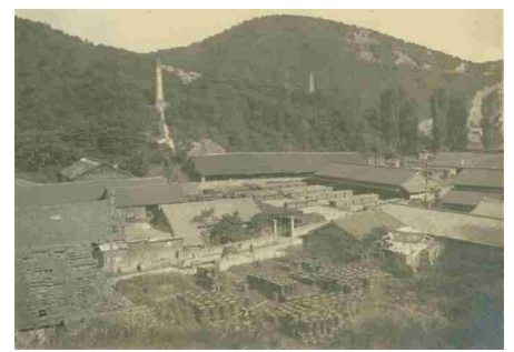
21 米子加藤煉瓦工場(全景)
