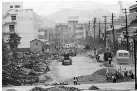
92 若桜街道の拡張工事
