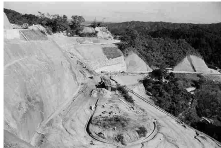
89 犬狹峠の改修工事
