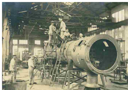
37 米子後藤工場(製罐工場)
