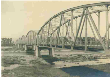
7 日野橋(新日野川橋)
