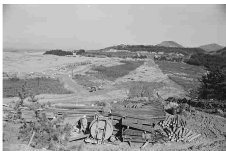
70 砂丘道路の建設
