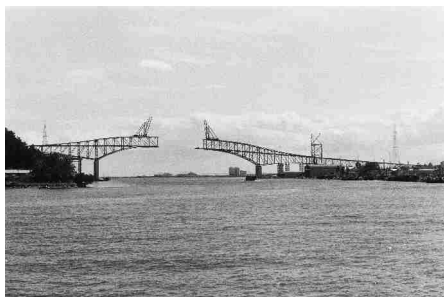
94 境水道大橋の建設
