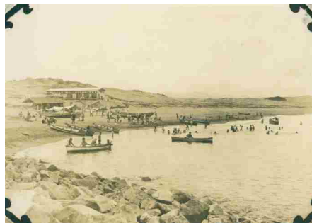
59 賀露海水浴場
