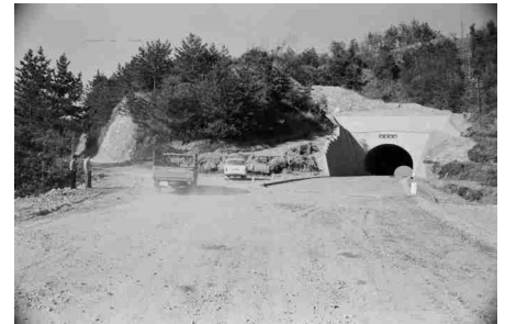
90 白兔隧道の建設
