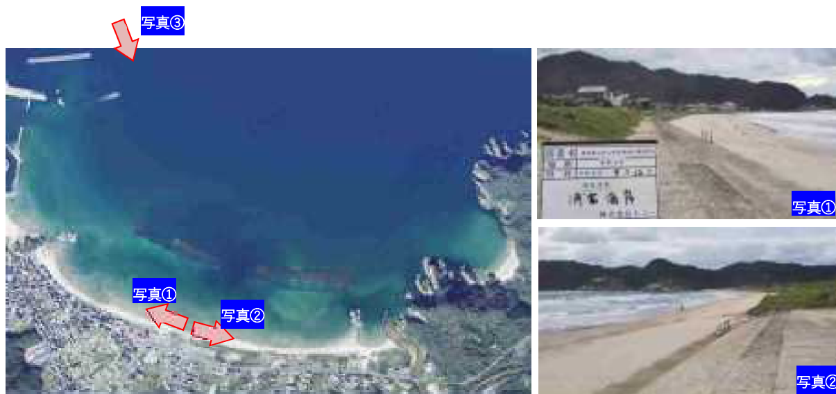
写真 1-3 岩美海岸（浦富地区）の航空写真（平成 30 年撮影）と現地写真
