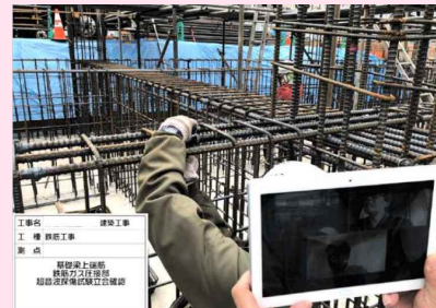
Webカメラを利用した遠隔検査
