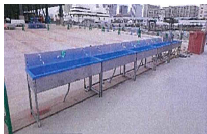
現場の手洗い場所の増設
