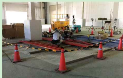
工事エリアの区画を設定して作業
