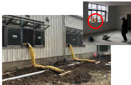
送風機を稼働し、埃を外部へ排出
