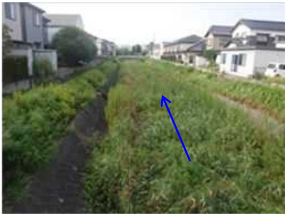
<大井手川放水路（鳥取市南安長）>
