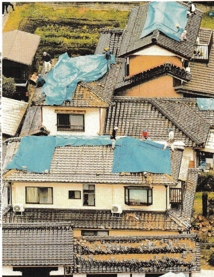
雨に濡れ、地震で壊れた屋根にブルーシートを張る人たち。22日午前、鳥取県倉吉市共同通信社ヘリから
