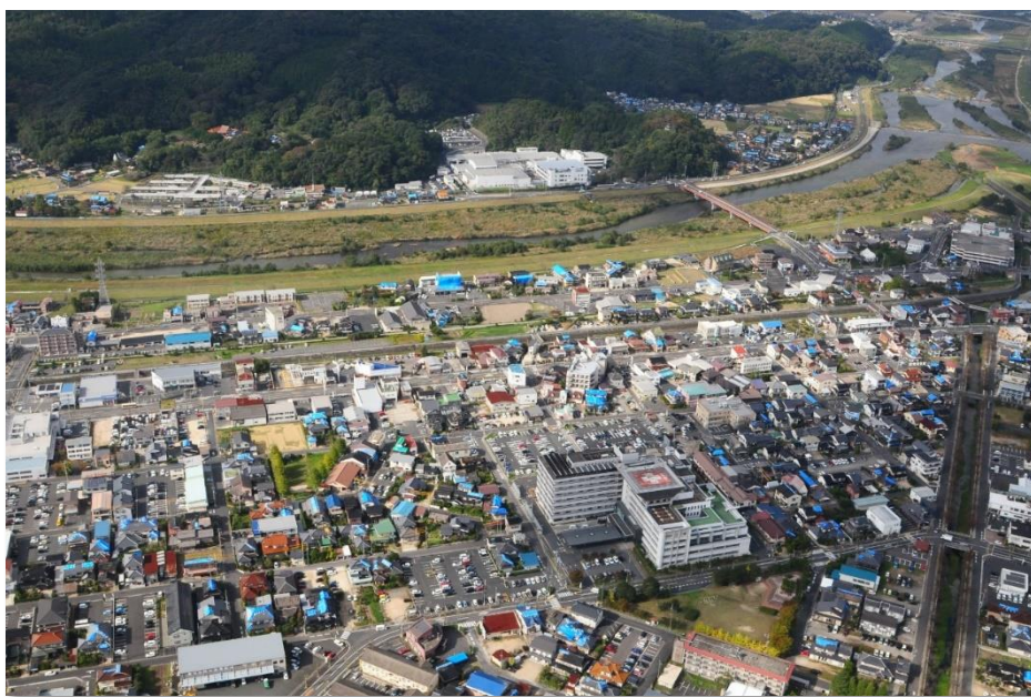
厚生病院周辺の被災状況(防災ヘリから撮影)
