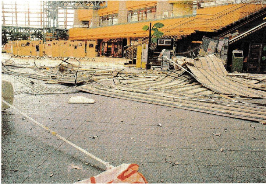
震度6弱の地震が激しい、エントランス付近の天井が落ちた倉吉未来中心。21日午後2時40分、鳥取県倉吉市駄経寺町
