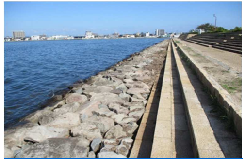
清掃後の湊山公園親水護岸
