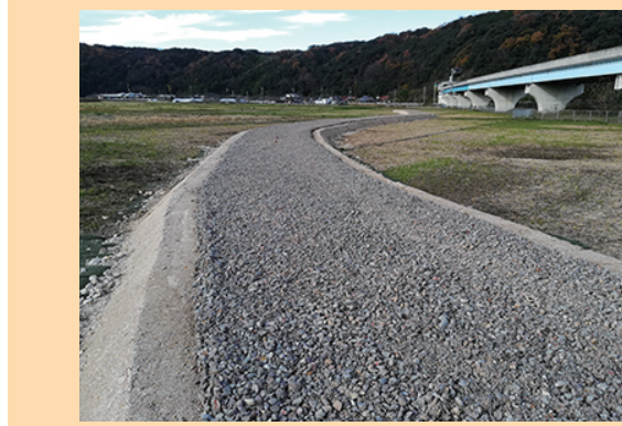
今年度は、工事用道路の敷設 ふせつ を行います。
