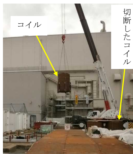
（主変圧器の吊り下げ）
