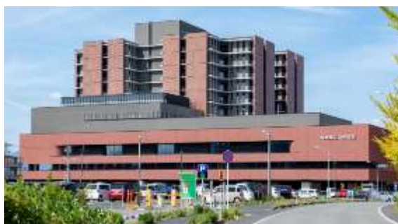
新病院の全景
