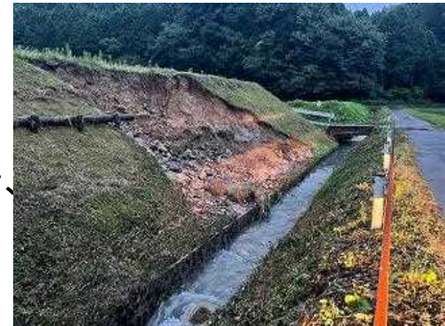
＜農地の法面崩壊(鳥取市鹿野町)＞
